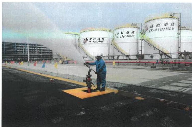
开启消防水炮
