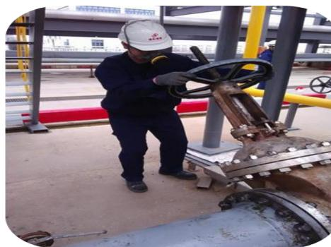
(4) 环境处置,码头班长组织人员对泄漏物料进行围堵吸附,在漏点正下方放置集液盆,泄漏周围铺设吸油毡,以防止泄漏物进入地沟和污水系统,减少物料的挥发,减少环境污染,与此同时码头当班人员滕伟使用可燃气体检测仪对周环境进行实时检测。
