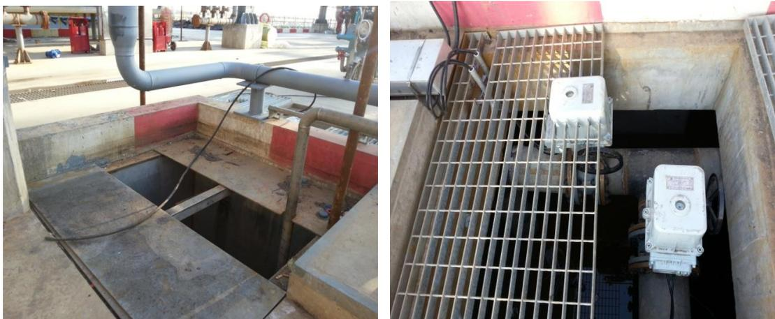
图 2.2-3 码头围污坎及污水泵
